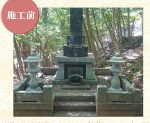
特殊な洗剤を使用してコケ・カビを落とします。古い目地を 切ってから水分などが入り込まない様、新たに目地の隙間を 丁寧にコーキングをしていきます。
